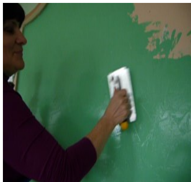
Рис. 2. Показ мастером производственного обучения технологии работы гладилкой
