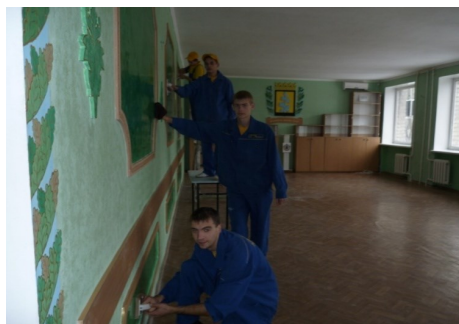
Рис. 3. Выполнение студентами работ по полировке оштукатуренной поверхности
