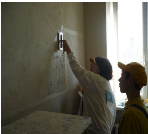
Рис. 1. Показ мастером производственного обучения технологии нанесения шпаклевочной массы для студента-левши
