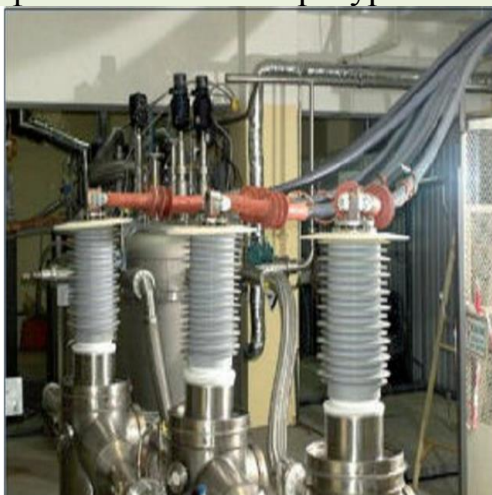
2. Кабель на основе эффекта высокотемпературной сверхпроводимости изготовлен во ВНИИКТ
